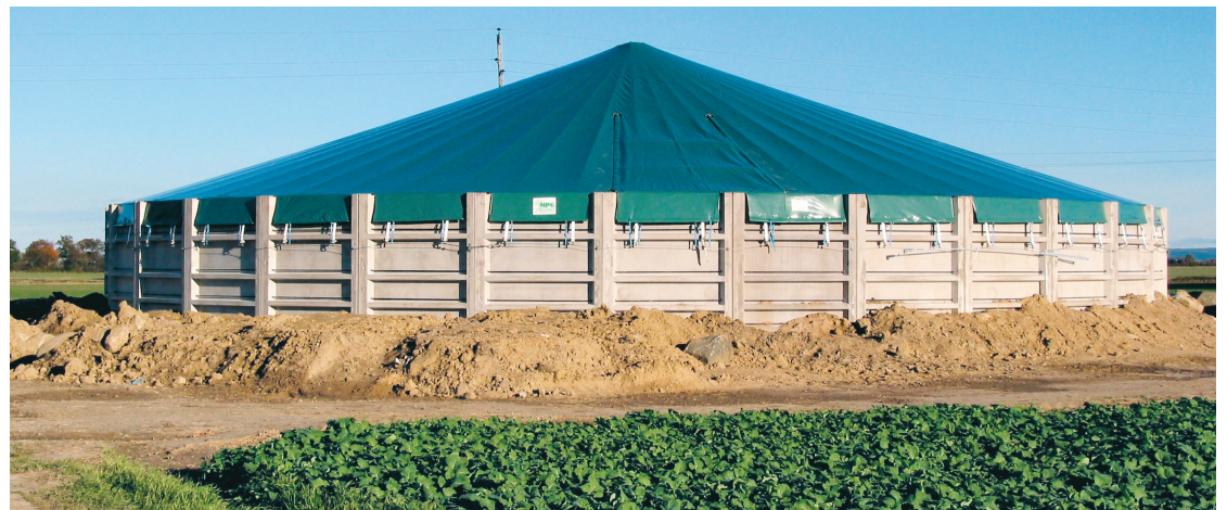
Tätslutande tak kan minska ammoniakavgången med upp till 95 procent.
