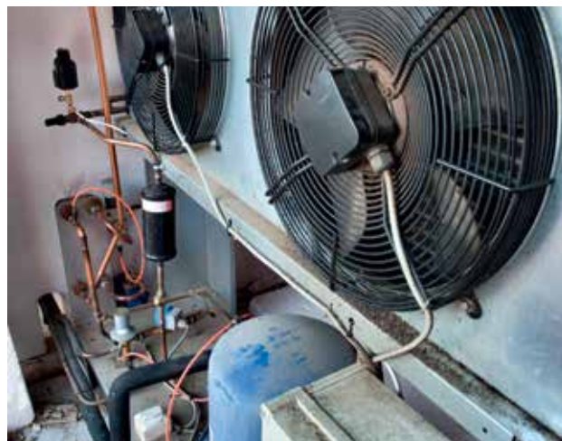
Se till så att kondensorn är väl ventilerad och att den hålls ren från damm och smuts.
