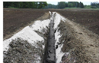
Strukturkalk i återfyllnadsmaterialet vid täckdikning ger effekt.
