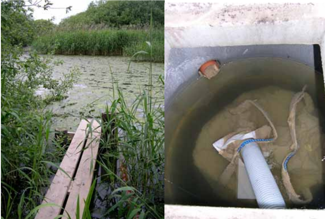
Bild 10 a) Våtmarken varifrån vatten leds till kalkfiltret för rening och b) filterkassetten i brunnen.
