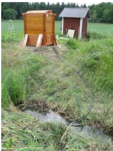
Provplats uppströms vattenföringsstation under byggnation i område U8
